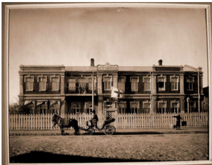
Рисунок 1 — Вид фасада здания Харбинской общины сестёр милосердия Красного Креста
